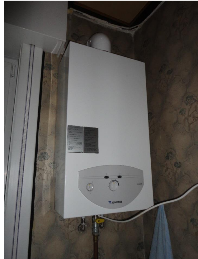
Toestel vervangen door een nieuw toestel type C (gesloten verbranding)
